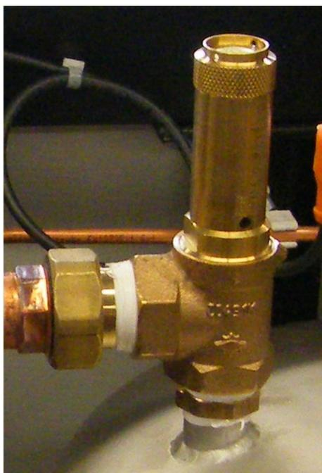
Las válvulas de seguridad forman parte de la grifería de seguridad y sirven para descargar la presión de los espacios sometidos a presión (calderas de vapor, recipientes a presión, tuberías, recipientes de transporte, etc.). Si la presión aumenta por encima de los valores máximos permitidos, las válvulas de seguridad se encargan de expulsar a la atmósfera los gases, vapores o líquidos.
