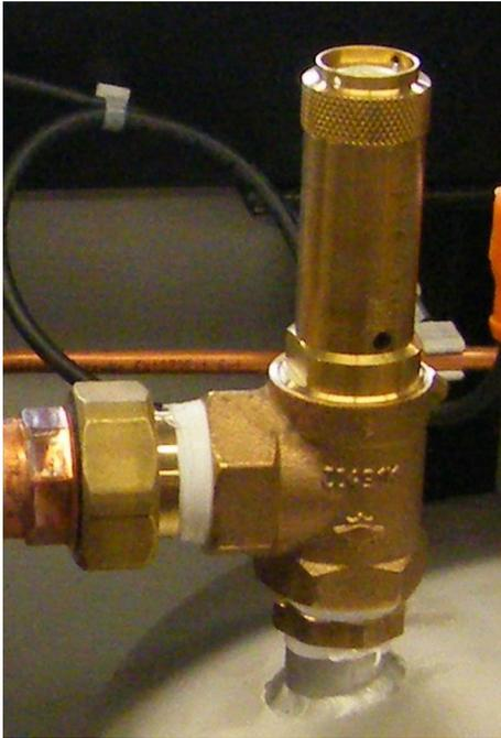
Sicherheitsventile gehören zu den Sicherheitsarmaturen und sind entlastende Vorrichtungen für druckbeaufschlagte Räume wie Dampfkessel, Druckbehälter, Rohrleitungen, Transportbehälter. Sicherheitsventile leiten bei einem unzulässigen Druckanstieg Gase, Dämpfe oder Flüssigkeiten in die Atmosphäre ab.
