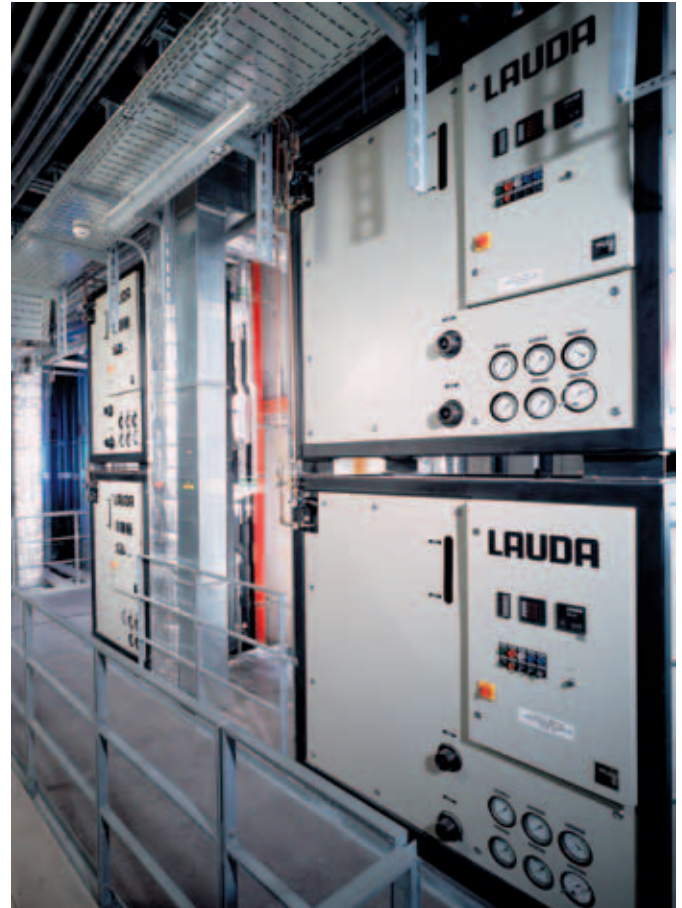
Une conception modulaire pour les systèmes de thermostatisation: ici dans le centre de production de Nycomed, à Singen en Allemagne
