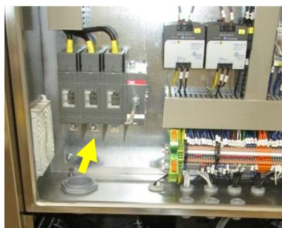
Per l'alimentazione elettrica dell'unità Ultratemp, utilizzare una linea elettrica appropriata in base ai dati nella targhetta delle caratteristiche.
